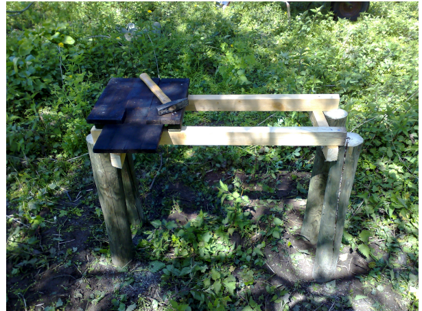
Abbildung 31: Dann zwei weitere Dachlatten angebracht. Darauf habe ich dann den Boden festgenagelt. Der Boden wurde mit Feuer "imprägniert"
