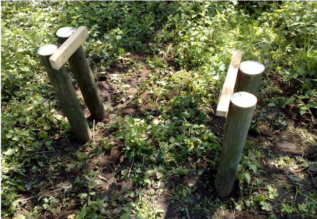
Abbildung 32: Die Pfosten werden in den Boden versenkt und zwei Querstreben in der Waagerechten angenagelt.
